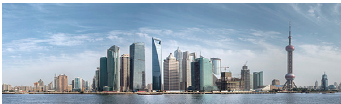
Blick auf Pudong
